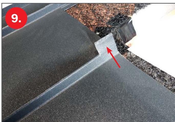
**9.** Příprava krytí na horním dílu zámku krytiny
