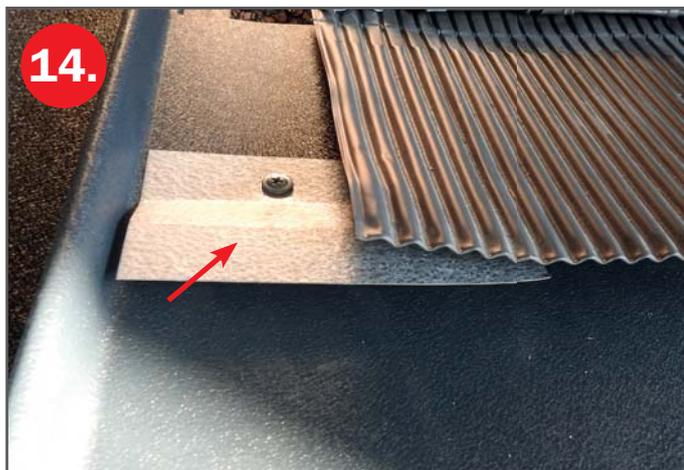
Délka Spojovacího plechu Rapid (SPR) musí být taková, aby tento díl zasahoval cca 50 mm pod manžetu. Spojovacího plechu Rapid (SPR) vždy podtěsníte tmelem, nebo butylkaučukovou páskou.
