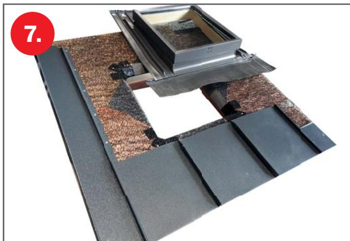
**7.** Příprava krytiny kolem výlezu. Montáž je možná jak z levé, tak z pravé strany. Úprava dílů krytiny pod výlezem.
