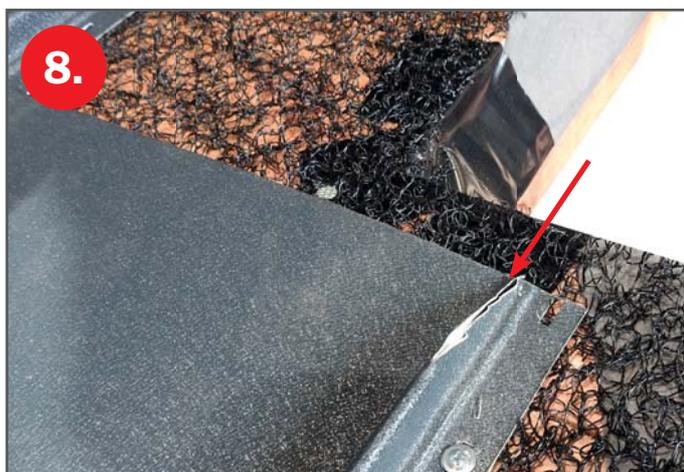
**8.** Zastřížení spodního dílu zámku krytiny z důvodu ochrany tvarovatelé manžety před roztržením
