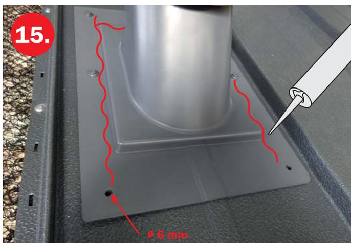
Otvory v prostupovém prvku pro kotvení do podkladu je potřeba odvrtnat vrtákem 6 mm. Prostupový prvek je potřeba ze tří stran podtmelit
