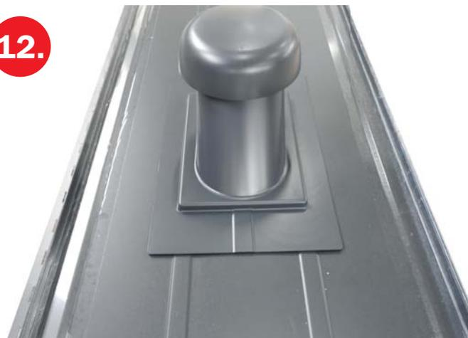
Do takto připraveného otvoru osadíme prostupující prvek a napojíme ho na komínek, nebo manžetu
